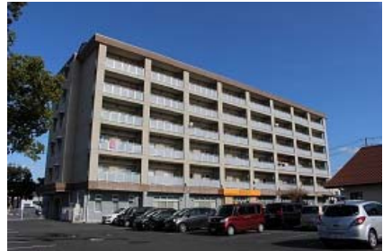
市営住宅（上灘町）
