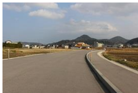
整備中の県道仙隠岡田線 （（都）生田小鴨線）
