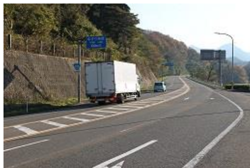
北条湯原道路（犬狹峠道路）
