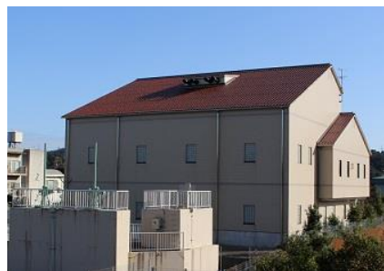
上井ポンプ場
