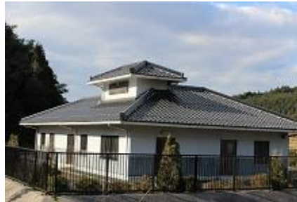
志村地区農業集落排水施設
