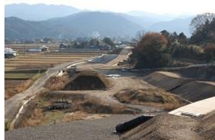
整備中の北条湯原道路
