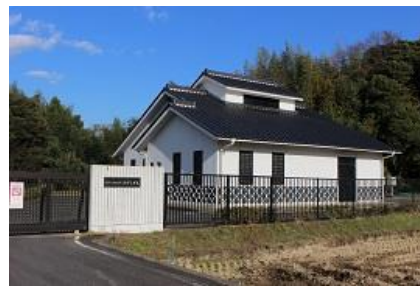
東鴨地区農業集落排水施設
