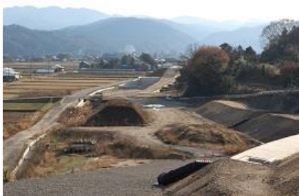
整備中の北条湯原道路
