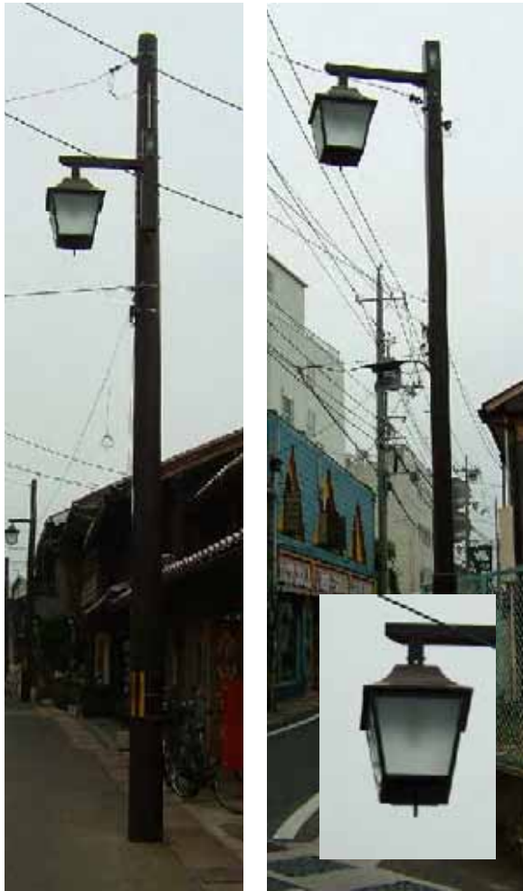
景観に配慮した照明施設の設置
