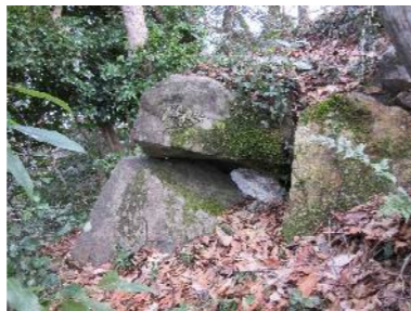
天守土台の石垣 主郭北東隅部石積
