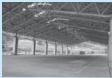
▲ゲートボールやレクリエーション会場として使用されている「屋根付多目的広場」
