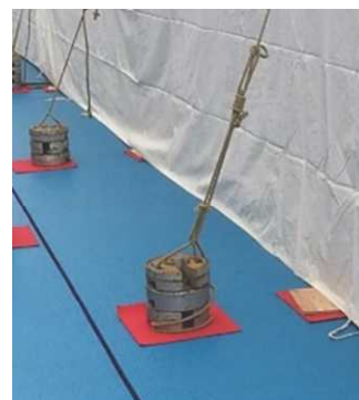
フェルトによる養生
