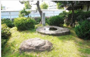
塔の心柱を支える礎石（奥）と 四天柱を支える礎石（手前）
