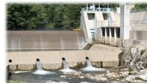
町営小水力発電所
