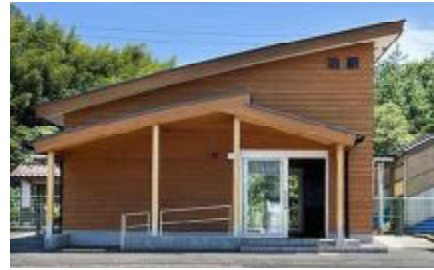
改修後のJR泊駅外観
