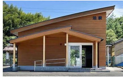
改修後のJR泊駅外観
