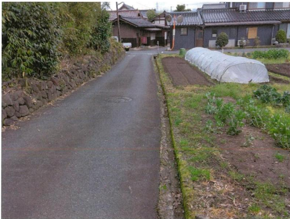
② 市道横田 9 号線道路側溝整備
