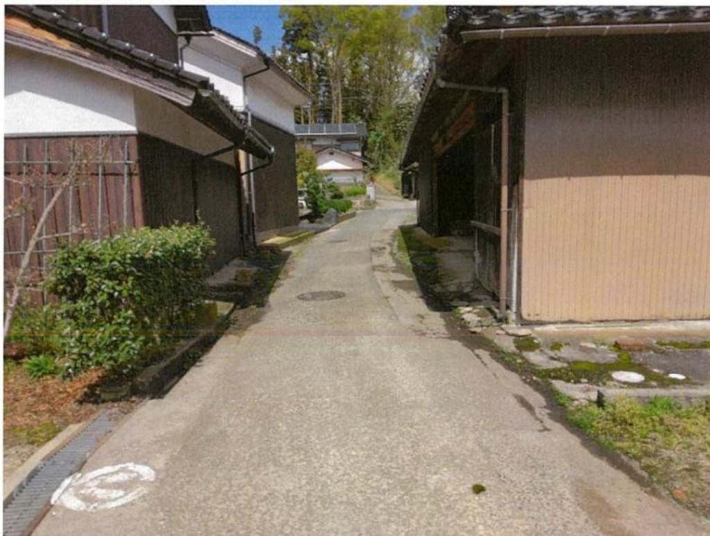
③ 市道横田 8 号線から市道横田上米積線間の生活道路側溝整備 市道横田上米積⇒市道横田 8 号線
