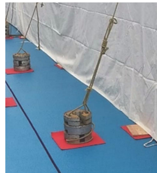
フェルトによる養生
