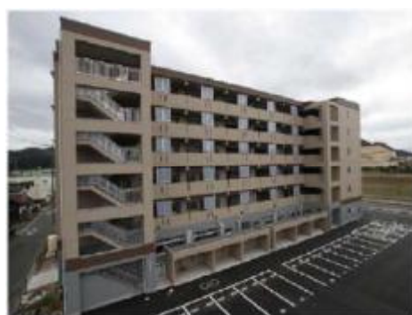
市営住宅（上灘町）
