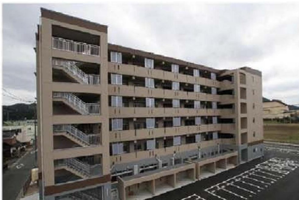
②⑤市営住宅（上灘町）
