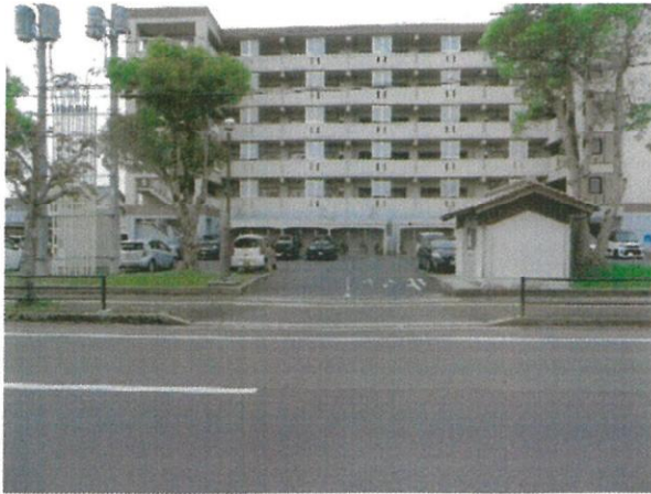
写真 4 ミラーの設置 うわなだ中央住宅
