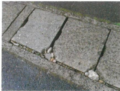
写真 2 側溝床板の修理 上灘町 55-2
