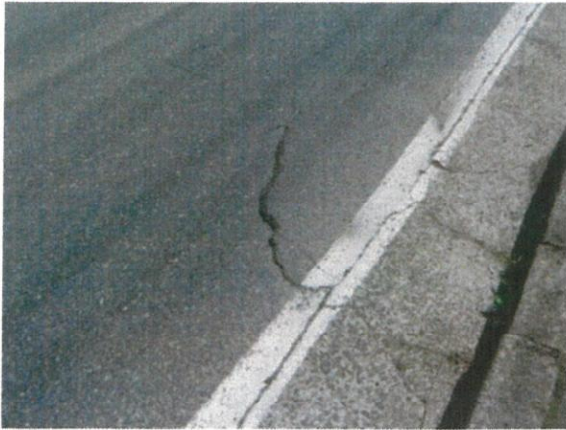
写真 1 歩道の修繕 オフィスK 前の道路表面
