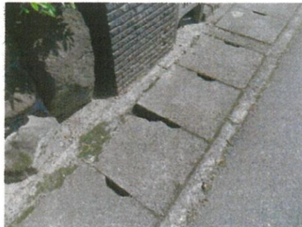
写真 2 側溝床板の修理 上灘町 55-2
