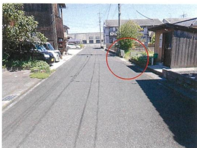
第1公園出入り口の改修箇所全景
