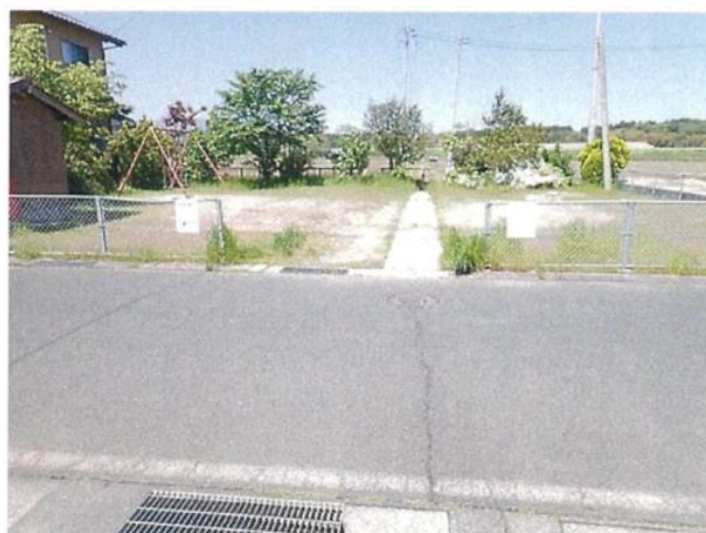
第2公園出入り口の改修
