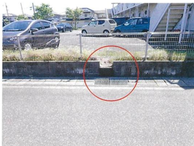
秋喜2号線の側溝の改修箇所
