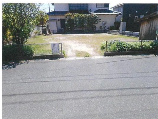
第1公園出入り口の改修
