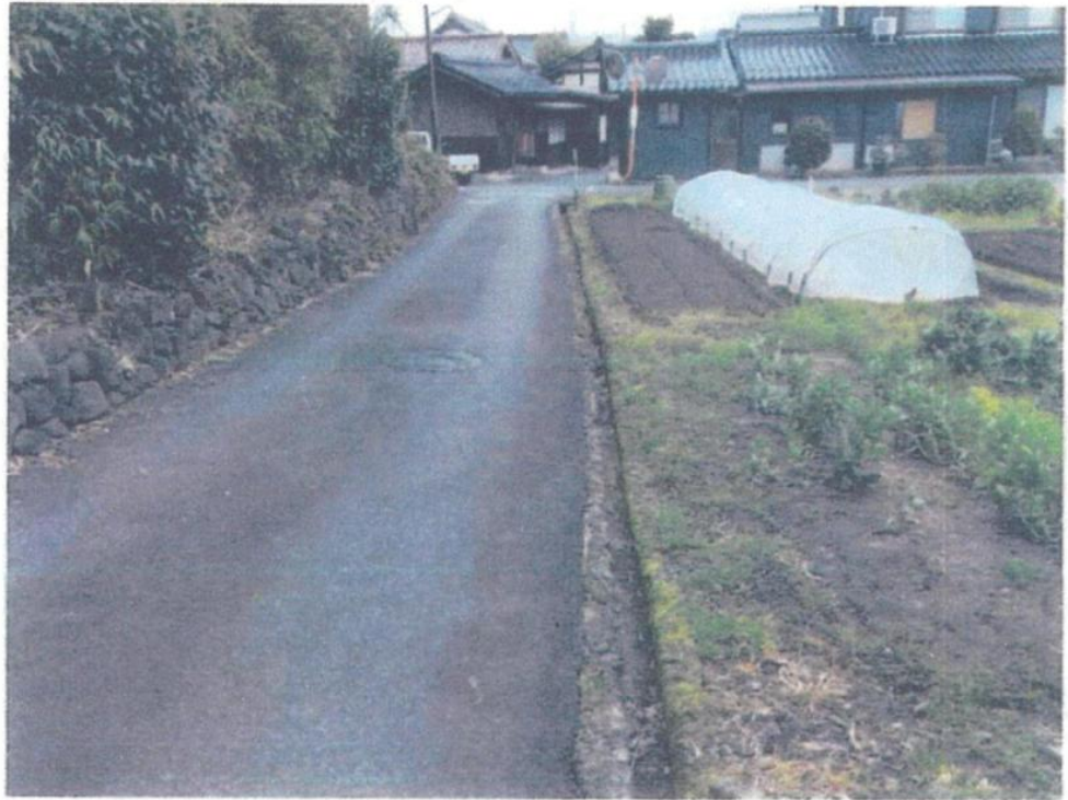
② 市道横田9号線道路側溝整備
