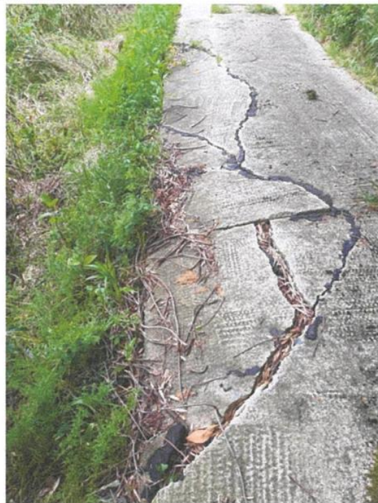
ひび割れ、陥没
