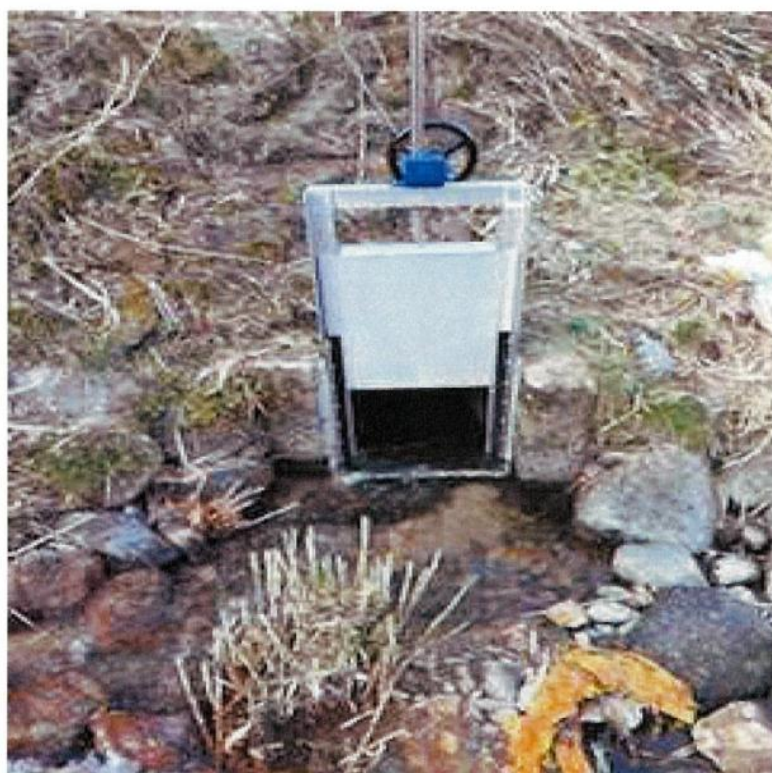
取水口 令和8年3月施工
