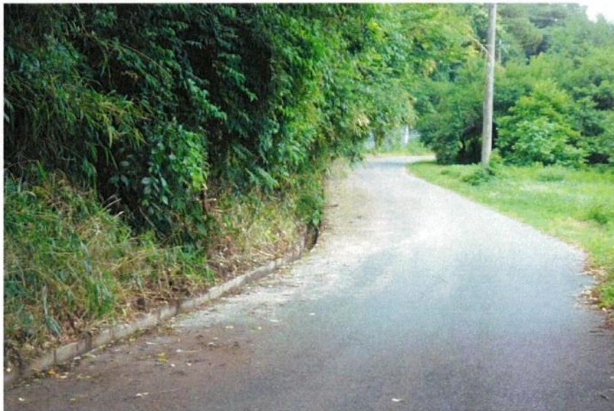
改善された側溝（写真⑤・1）
