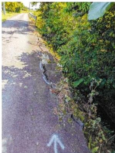
2-⑤泰久寺地区内・開田上野部線の路肩補修 2026/05/18 現在
