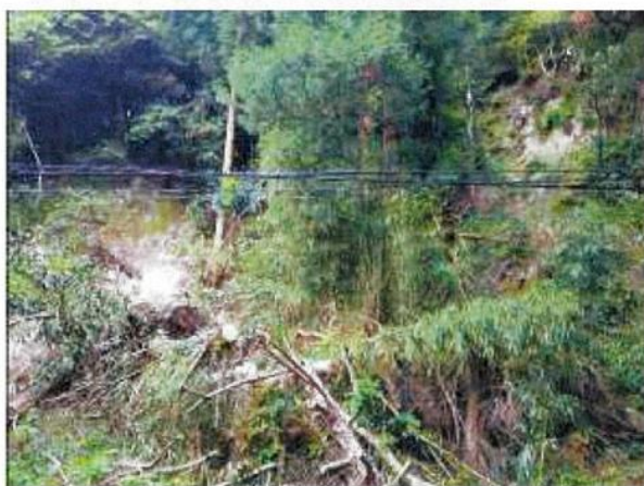
崩れた法面と倒木③
