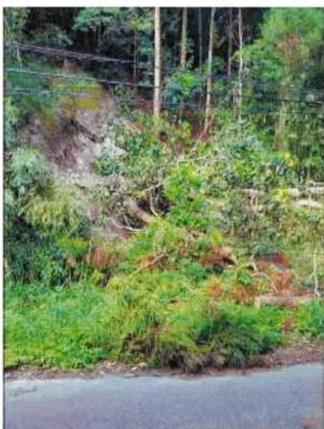
崩れた法面と倒木① 〔崩地内〕
