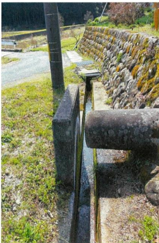
③ゲートより落ちコンクリート壁にて側溝へ
