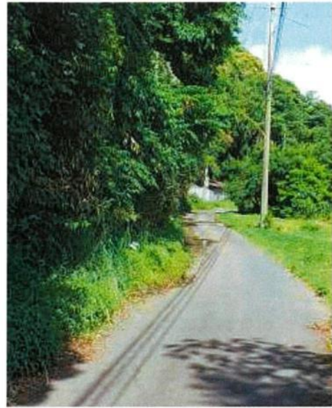
側溝が埋まってしまった市道陽線④・2 〔崩地内〕
