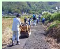
未舗装農道の舗装
