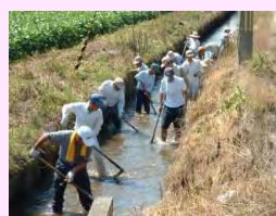
水路の泥上げ
