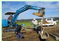
コンクリート水路の更新
