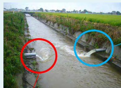
田んぼダム実施
