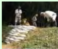
漏水箇所の補修
