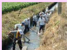
水路の泥上げ
