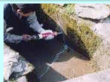
水路のひび割れ補修
