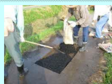
農道の部分補修
