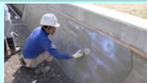
老朽化した水路壁のコーティング
