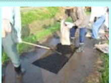
農道の部分補修
