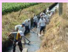
水路の泥上げ
