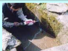
水路のひび割れ補修
