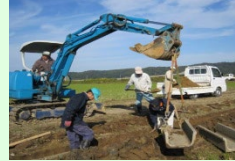
コンクリート水路の更新
