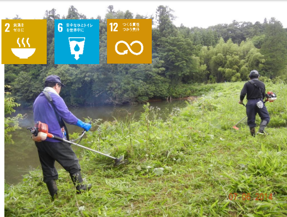
ため池堤体の草刈り
