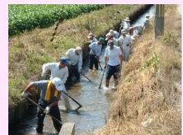
水路の泥上げ
