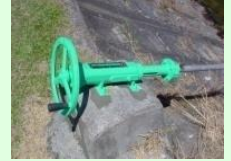
ゲート、バルブの更新
