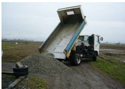
砂利の荷下ろし
