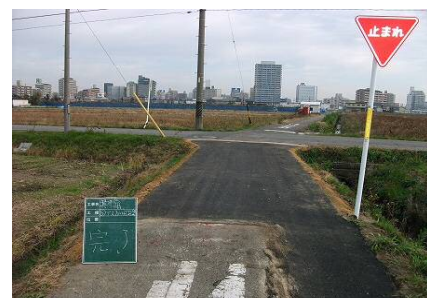
アスファルト舗装の打換え
