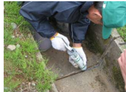
シーリング材充填
