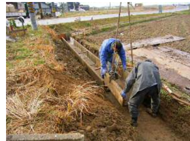
水路の再布設
