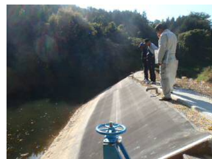
遮水シートの設置
