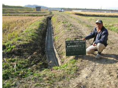
土側溝をコンクリート側溝に更新
