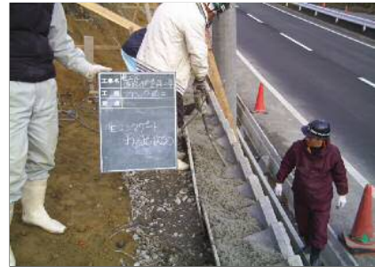
ブロック積みの施工
