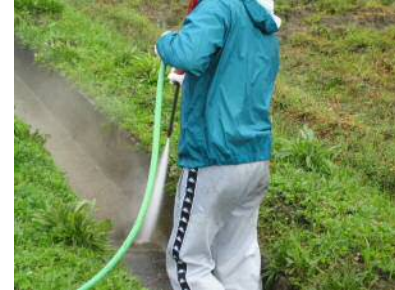
高圧洗浄機による 水路内の清掃
