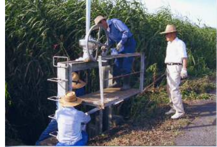
ゲートの点検
