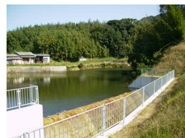
金網フェンスの 設置状況
