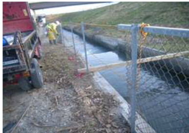
金網フェンスの 設置
