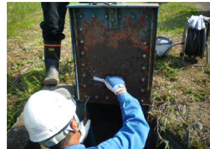
ゲートの補修状況
