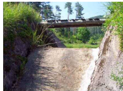
洪水吐の補修
