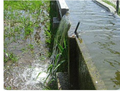
水路からの部分的な溢水
