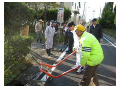
水路蓋の設置 (専用器具使用)
