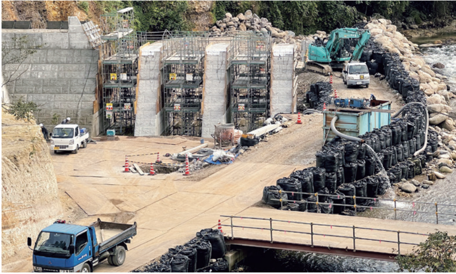
土石流を防ぐ砂防工事。
