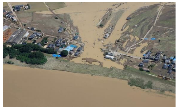
堤防決壊による家屋の流失(鬼怒川)
