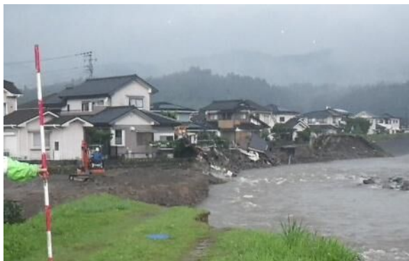
河岸侵食による家屋の倒壊(花月川)
