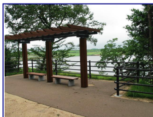
遊歩道(休憩所)
