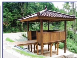
遊歩道(休憩所)
