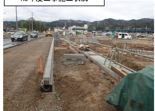
R5年度工事施工状況
