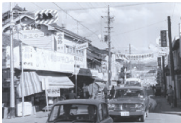
③1963(昭和38)年 明治町交差点に信号機設置
