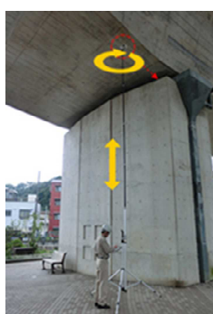
ロボットカメラを使用した点検例
