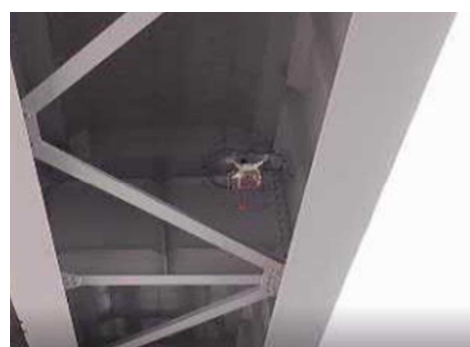
ドローンによる点検例
