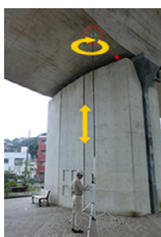
ロボットカメラを使用した点検例
