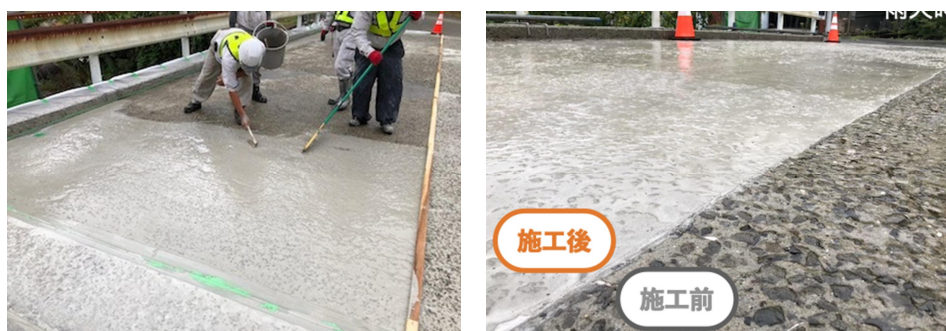
「コンクリート舗装用床版防水工法」【NETIS KK-230060-A】
