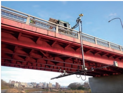
橋梁点検支援ロボットによる点検例
