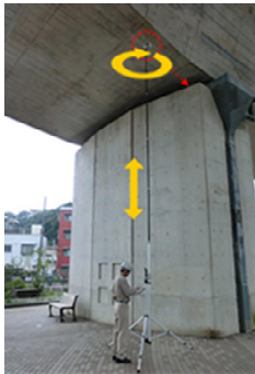
ロボットカメラを使用した点検例
