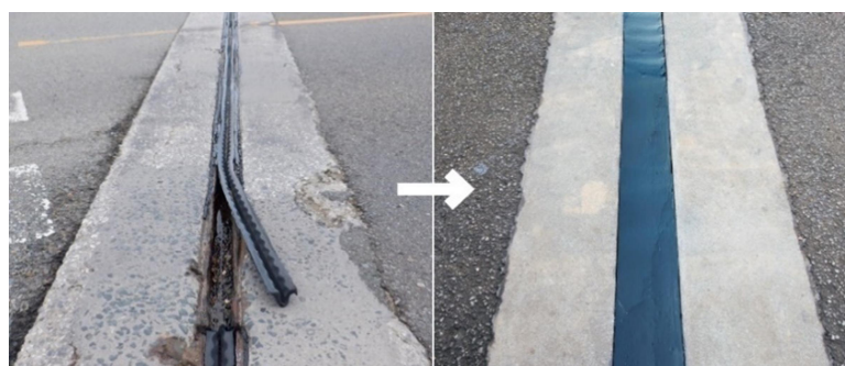
「ゴム劣化取替工法」【NETIS QS-180049-A】
