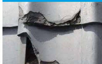
瓦が著しく破損している例
