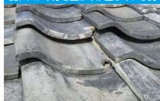
瓦が著しく破損している例
