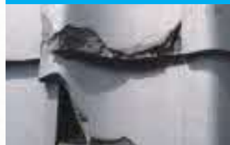
瓦が著しく破損している例
