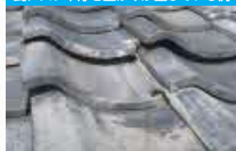
瓦が著しく破損している例
