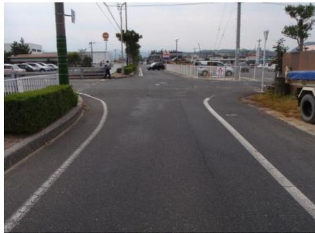
【歩道境界ブロックの低さが低く、歩道内への車両の突込みが危険である。】
