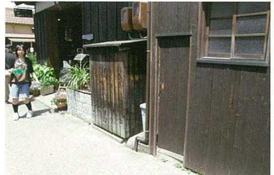
中央の扉の内側にガスボンベとガスメーターがある。完全に密閉するとガス事故につながるので空気がぬける隙間を造っている。
