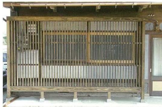
電気メーターを格子の箱に納め、目立たなくしている例。
