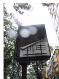
シート材がはがれかかった状態
