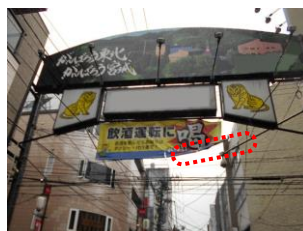
幕材を張る部材が破損した 状態
