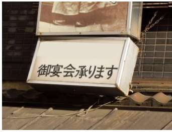
屋外広告物本体の傾き
