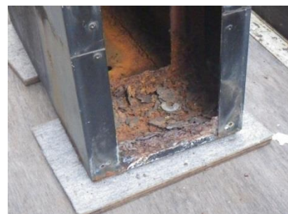
底部が腐食していた看板の例
