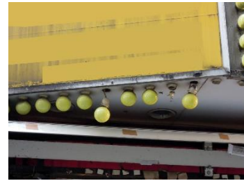
照明器具の傾き、外れ
