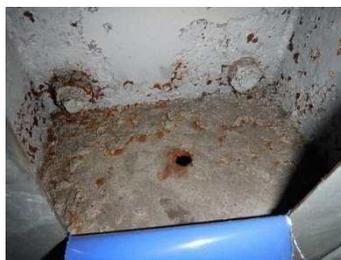
ブラケットの腐食が進行し、劣化した状態
