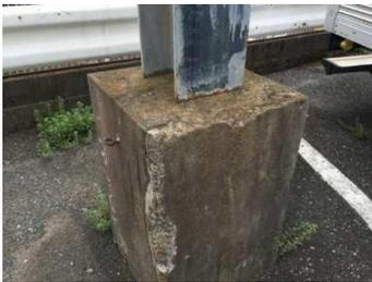
根巻きコンクリートが劣化し、欠けた状態
