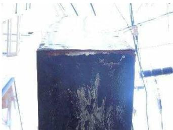
側板底面にさびが発生した状態
