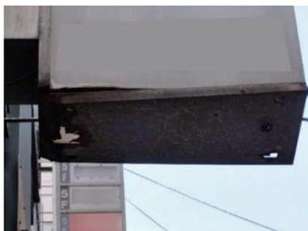
側板底面が腐食、破損、変形した状態
