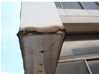
側板の腐食が進行した状態
