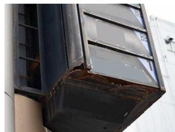
側板底面が腐食、破損した状態
