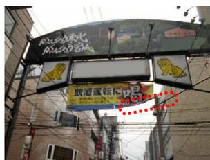
幕材を張る部材が破損した
