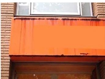
側板の腐食が進行した状態
