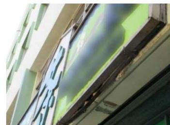
側板底面が破損した状態
