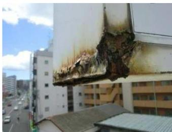
側板の腐食が進行した状態
