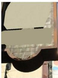
側板底面の腐食が進行した状態
