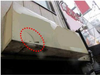
表示面板が破損（ひび割れ）した状態
