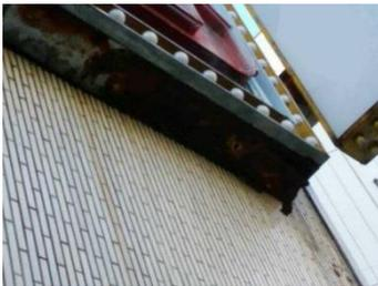
取付部の腐食が進行、汚ダレが見られる状態
