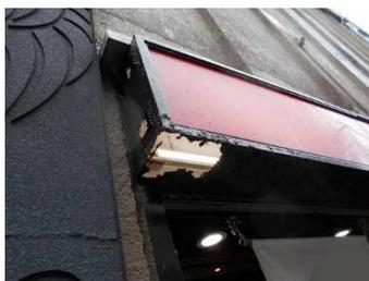
側板底面の腐食が進行した状態
