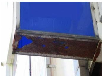
側板底面が腐食、破損した状態
