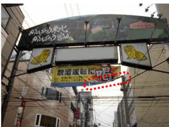
幕材を張る部材が破損した状態
