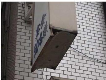
表示面板が外れかかり、押された表示面板押さえが変形した状態
