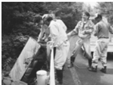
▲清掃作業の様子
