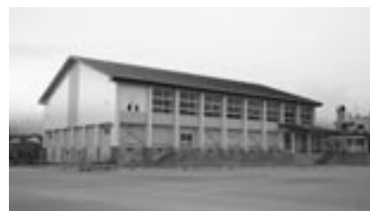
12月現在 鴨川中学校屋内運動場
