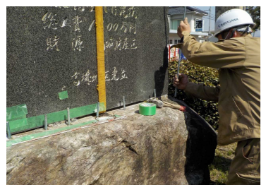
接着面は鉄骨で補強しました
