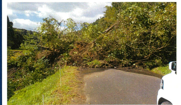
土砂崩れにより完全に遮断された椋波方面への道路(10/1)
