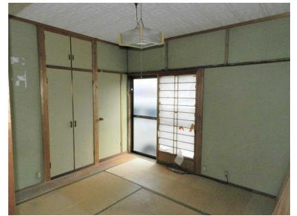
1階 和室(増築部分)
