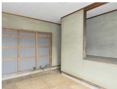
1階 倉庫(増築部分)
