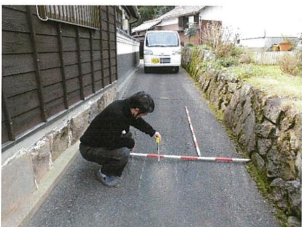
⑦古川沢 2 号線舗装陥没全景
