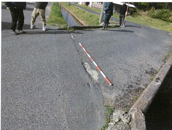
③古川沢 1 号線舗装クラック、陥没全景
