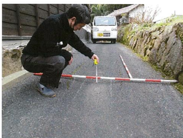
⑦古川沢 2 号線舗装陥没近景
