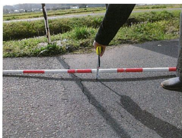
⑥古川沢 1 号線舗装沈下近景
