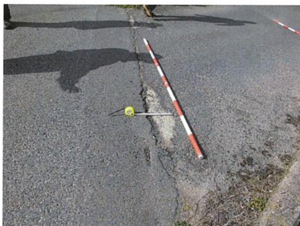
③古川沢 1 号線舗装クラック、陥没近景
