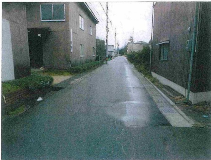
福守町自治公民館 令和6年度陳情要望 要望書④ 市道西倉吉町鴨川町2号線の外側線について 福守町282-1附近より上方向 外側線
