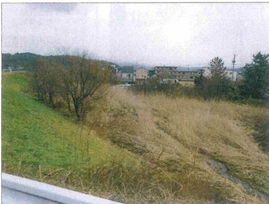
福守町自治公民館 令和6年度陳情要望 要望書③ 守護分地区内水対策について 守護分地区内面 樋門より上流方向
