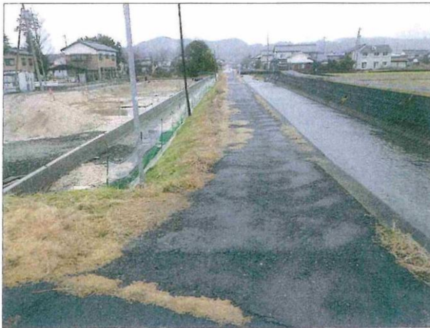
福守町自治公民館 令和6年度陳情要望 要望書② 鴨川堤防除草について 福守橋より下流方向
