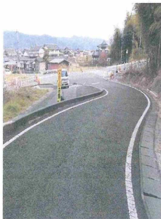
新しい県道と交差する生田北野線 (坂から下る西側からの写真)
