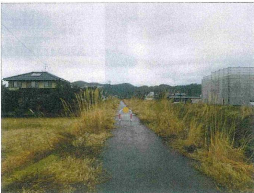
福守町自治公民館 令和6年度陳情要望 要望書② 鴨川堤防除草について 福守町95-5附近より下流方向
