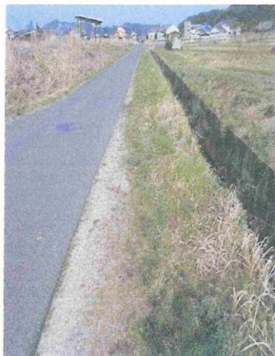
雑草が生い茂ると幅員更に未整備道路（南側からの写真）
