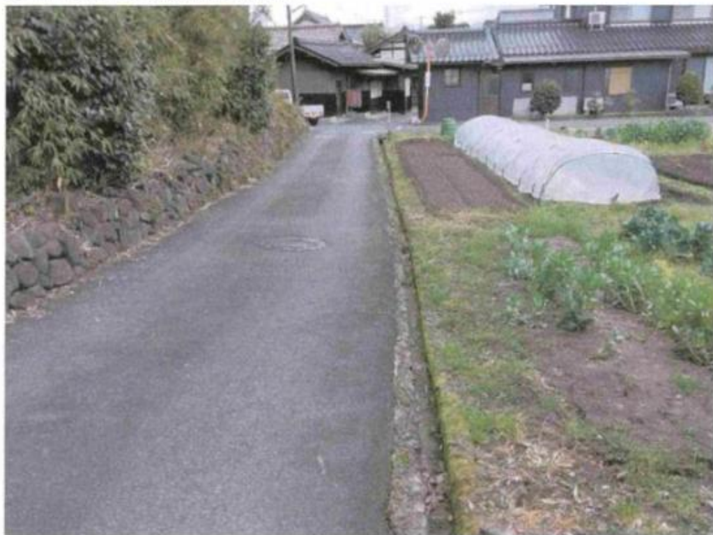
② 市道横田 9 号線道路側溝整備
