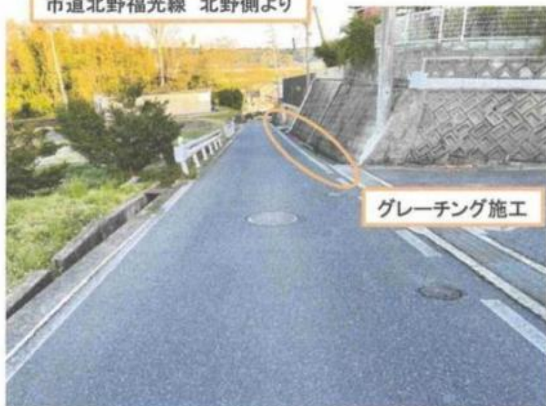
市道北野福光線 北野側より
