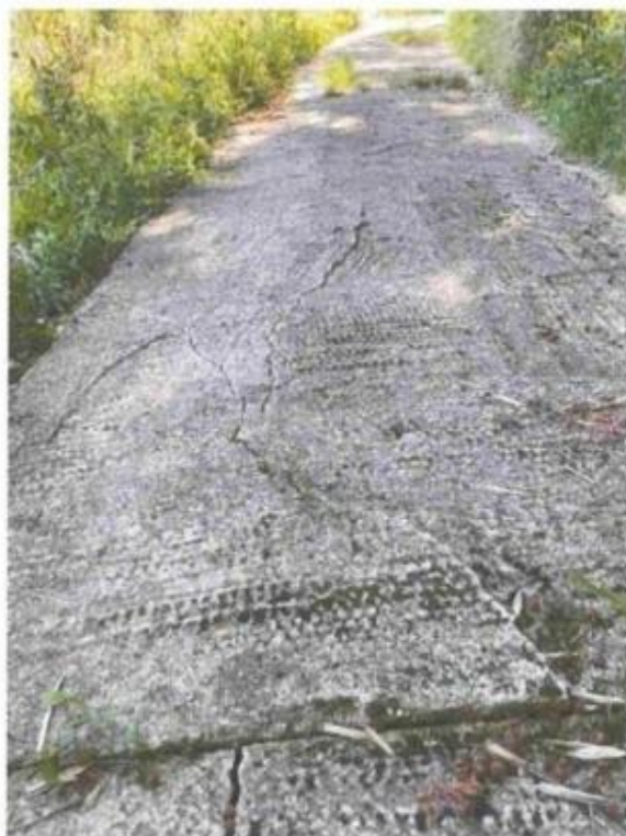
ひび割れ、陥没
