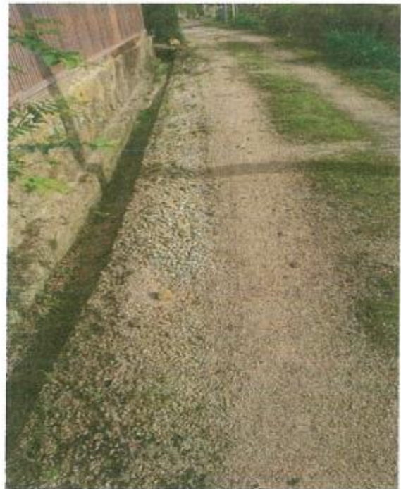
雨水で真砂土が流れている
