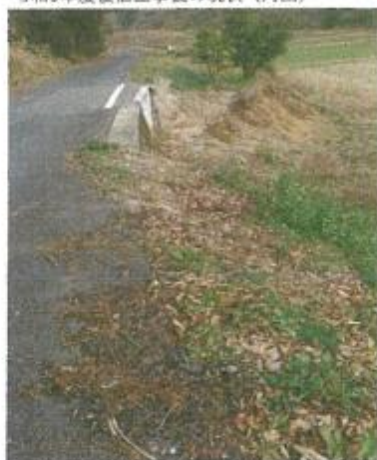
令和5年度復旧工事後の現状（角田）
