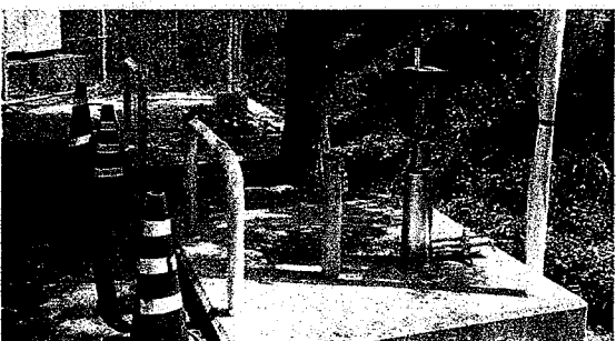
完成した防災井戸(河北小学校)
