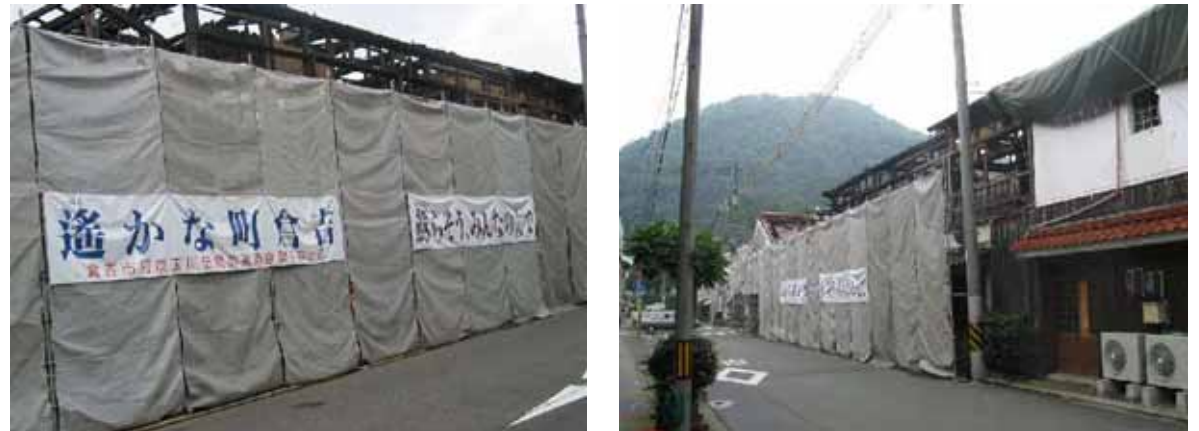
火災直後の状況
