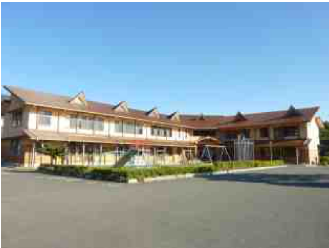
写真①（校舎外部）
