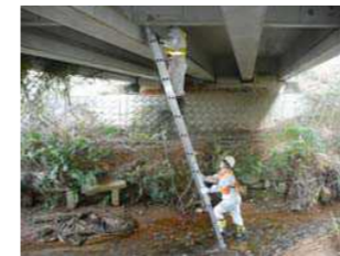
■橋梁点検の様子
